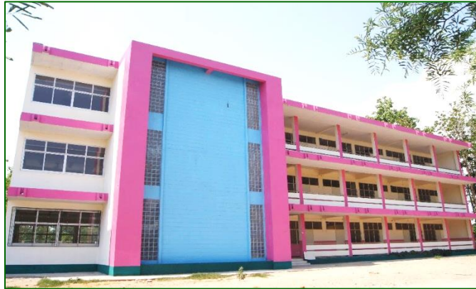
อาคารเรียน ม.ต้น ประกอบด้วยห้องต่างๆ ดังนี้
